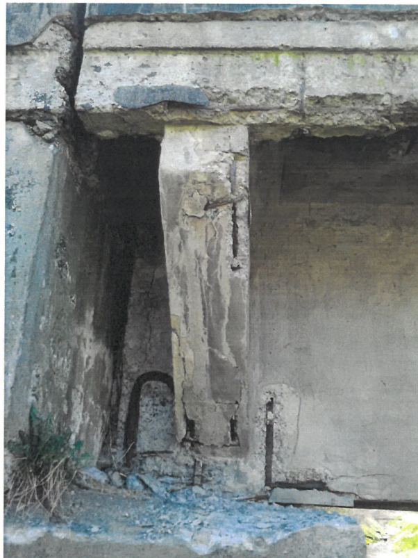
Obrázok 24 Rozpad betónu na priečnikoch a trámoch NK
