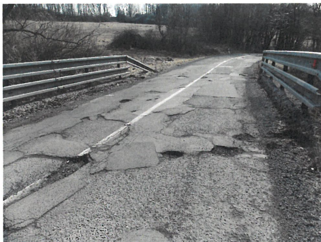
Obrázok 45 Porušený asfaltový kryt na moste 527-036
