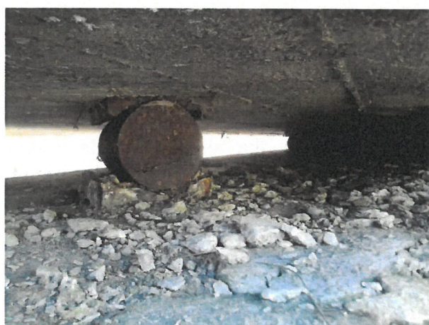
Obrázok 10 Detail na valcové ložisko
