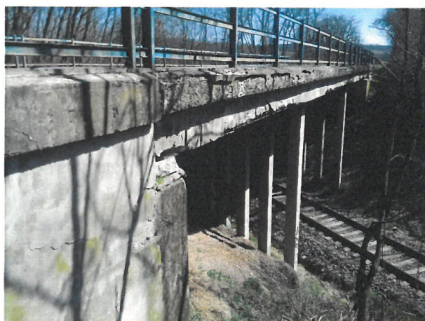
Obrázok 8 Rozpad betónu a obnaženia ťahovej výstuže
