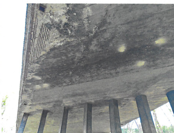
Obrázok 9 Obnaženia ťahovej výstuže na NK
