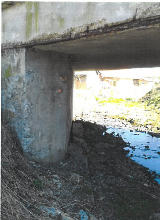
Obrázok 44 Rozpad ochrany základov opôr
