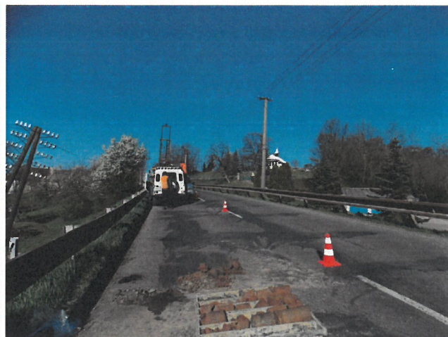
Obrázok 35 Vrtý a sondy na ceste II/526 v km 4,152-4,290 v obci Bzovík
