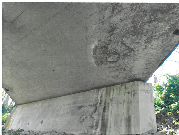
Obrázok 6 Pohľad na oporu v smere Senohrad a prasklinu na NK
